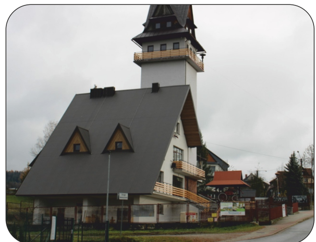
Remont dachu na Domu Kultury w Maniowach
