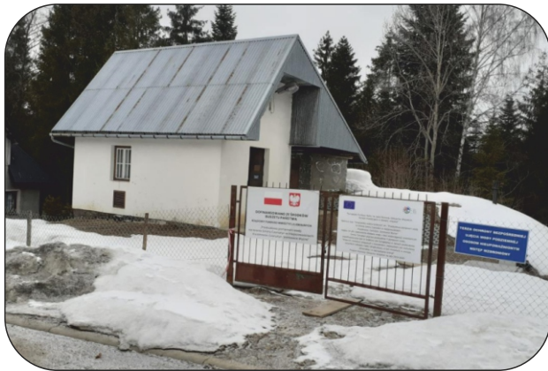
Przebudowa pompowni wody w Czorsztynie
