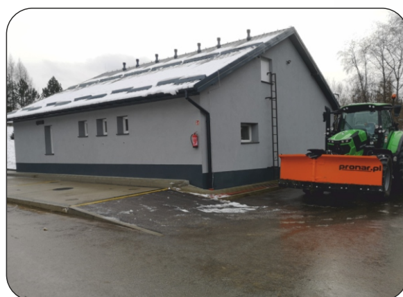
Budynek PSOK w Maniowach
