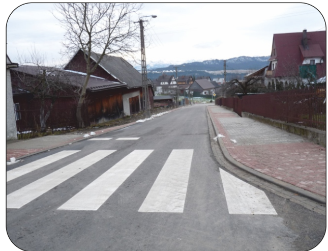
Remont ulicy Sienkiewicza w Maniowach
