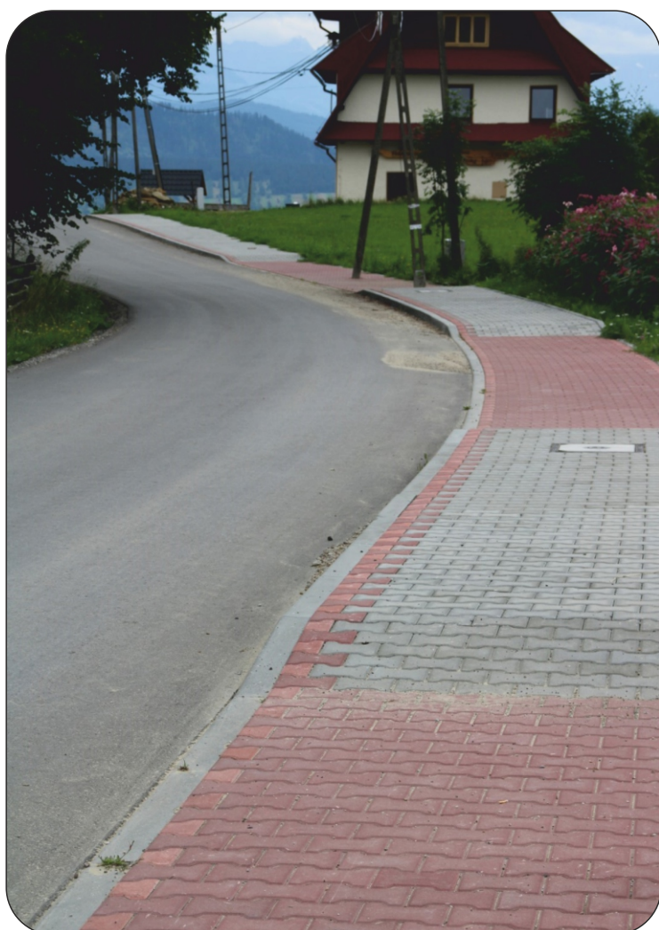
Budowa chodnika w Hubie
