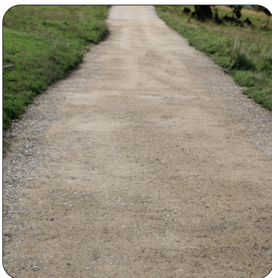
Modernizacja drogi dojazdowej do pól w Kluszkowcach
