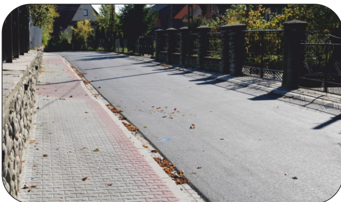
Wyremontowana ulica Żeromskiego w Maniowach
