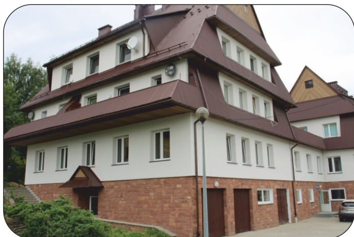
Wyremontowany budynek ośrodka zdrowia w Maniowach
