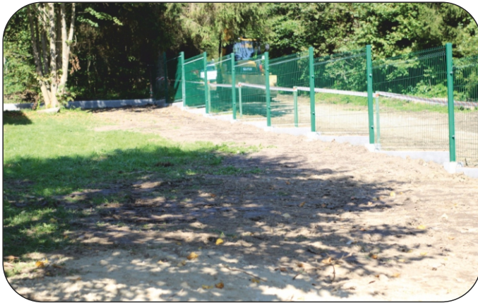
Modernizacja placu wokół stacji uzdatniania wody w Kluszkowcach
